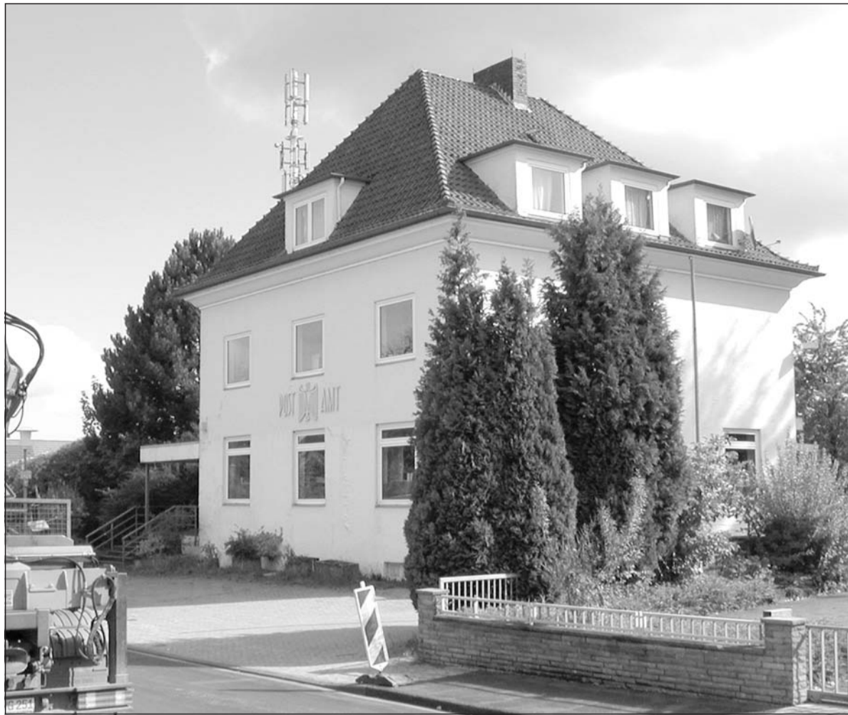
Das alte Jöllenbecker Postamtsgebäude an der Bahnhofsplatz, der heute als Veranstaltungsfläche für Feste wie den »Jürmker Klön« genutzt wird.
